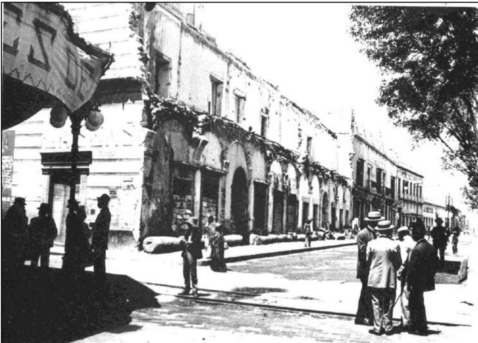
Figura II.15 Demolición del Portal de Carmelitas 1916.
