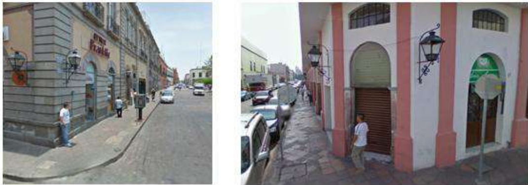
Figura II.42 Luminarias de tipo candil instaladas en calles del perímetro "A" de la zona de Monumentos.
