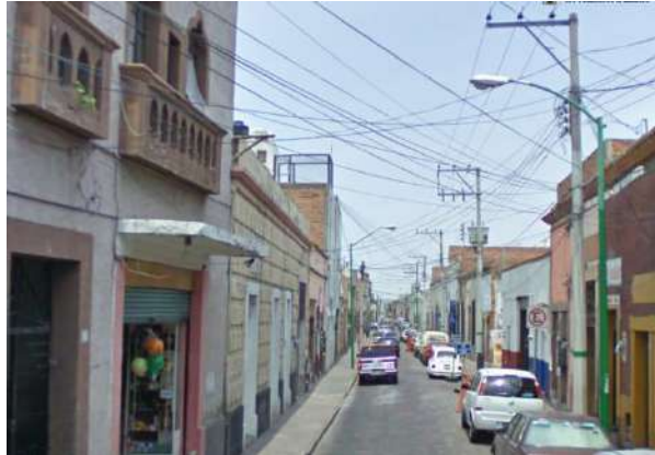
Figura II.43 Calle ubicada en el perímetro “A” de la zona de monumentos donde se tienen luminarias con postes de 7 metros.
