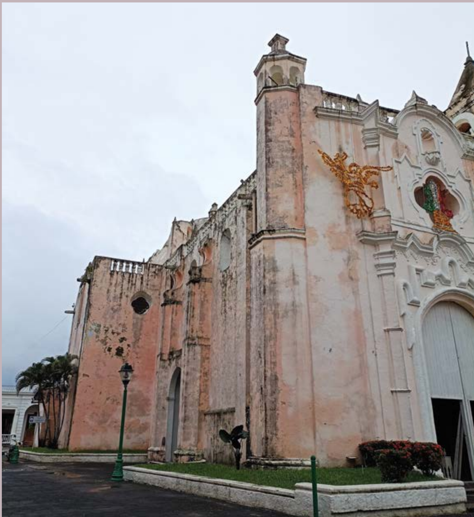
Retiro de aplanados y estucos en mal estado en el proceso de restauración del Santuario de Ntra. Sra. de la Candelaria, Tlacotalpan, Ver. • Antes
