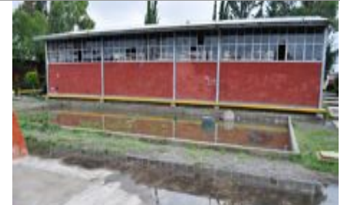
Equipamiento educativo deteriorado
